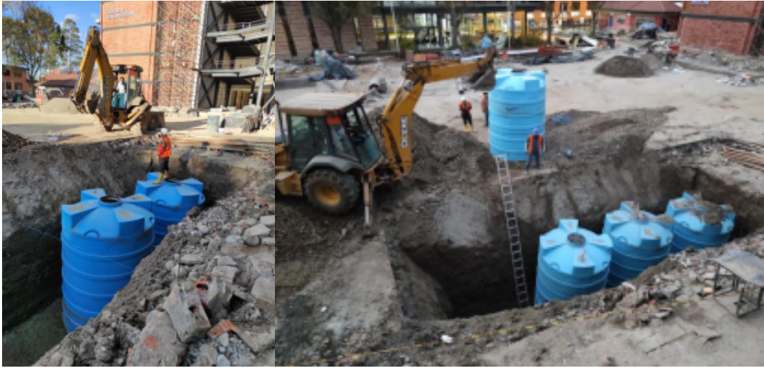
Imagen 04,05. Fotografías tanques enterrados, elaboración propia
