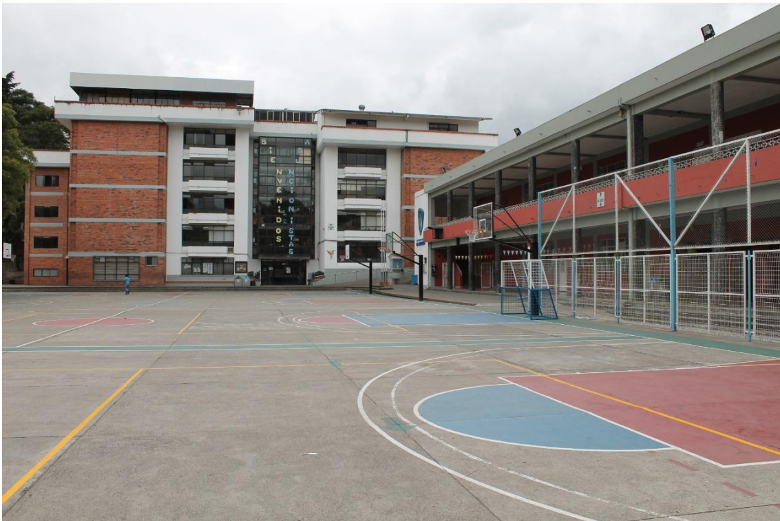
Anexo 22: Edificio estado anterior.
