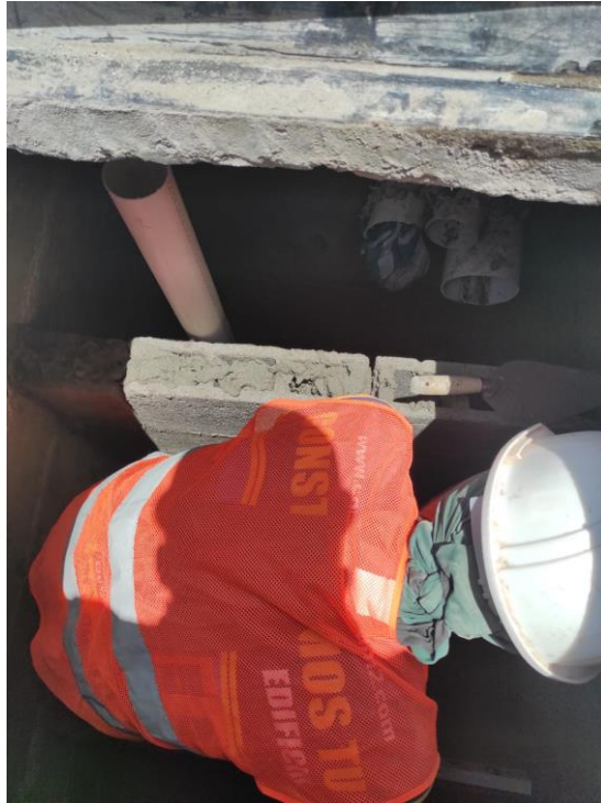
Anexo 4: Construcción de pozos de revisión.
