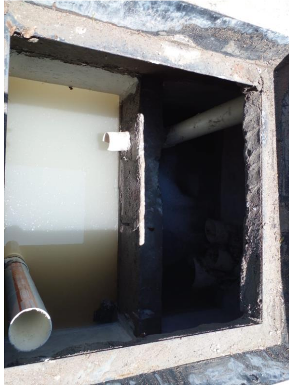
Anexo 7: Interior pozos de revisión.
