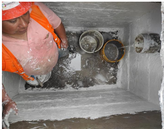
Anexo 5: Impermeabilización pozos de revisión.
