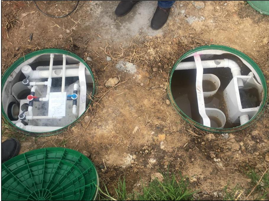
Foto 2: Proceso de instalación de tanque.
